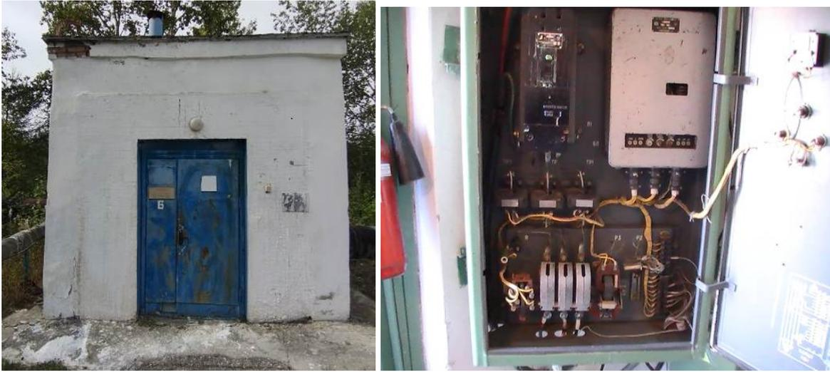
Рис. 1.13. Павильон с электрическим щитом и приборами учета электроэнергии артезианской скважины №6а Тыйского водозабора
