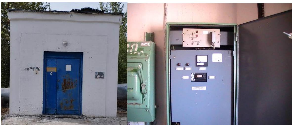
Рис. 1.11. Павильон с электрическим щитом и приборами учета электроэнергии артезианской скважины №4 Тыйского водозабора
