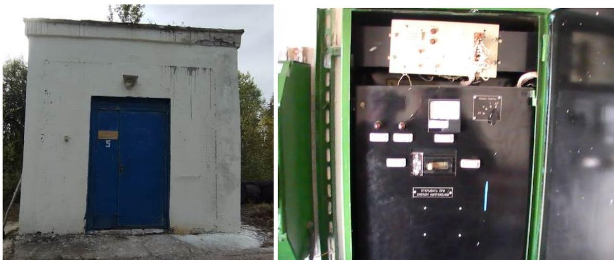
Рис. 1.12. Павильон с электрическим щитом и приборами учета электроэнергии артезианской скважины №5 Тыйского водозабора
