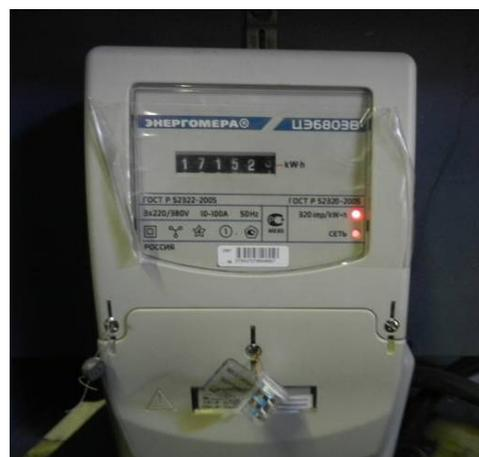
Рис. 1.21. Павильон с электрическим щитом и приборами учета электроэнергии артезианской скважины №9 мкр. Заречный
