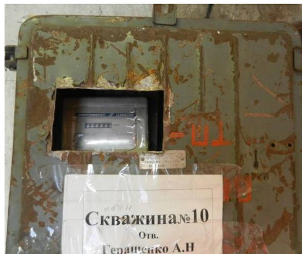
Рис. 1.19. Павильон с электрическим щитом и приборами учета электроэнергии артезианской скважины №10 мкр. Заречный
