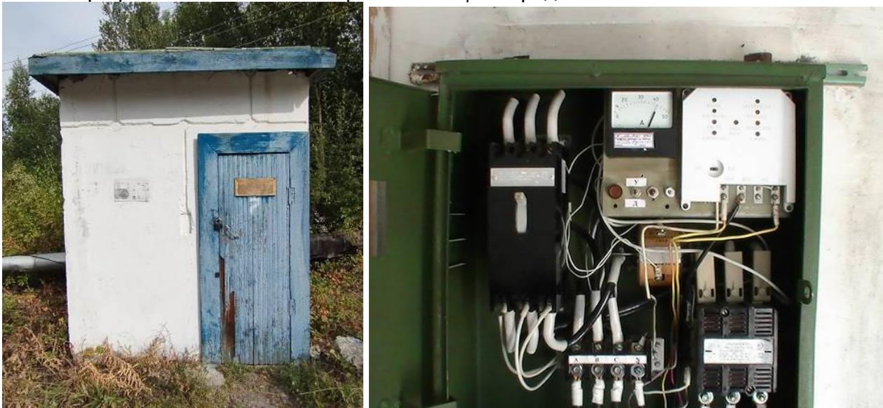
Рис. 1.14. Павильон с электрическим щитом и приборами учета электроэнергии артезианской скважины №7 Тыйского водозабора
